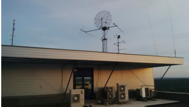
Obrázek 2: Anténní systém pozemního segmentu VZLUSAT-1 a PilsenCUBE na budově FEL ZČU
