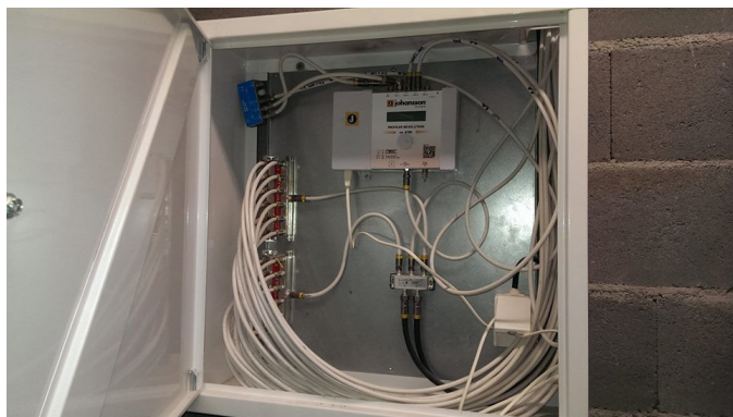
Obrázek 2: Programovatelný zesilovač pro STA
