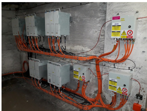
Obrázek 1: RRU „hnízdo“ s napájecími boxy
