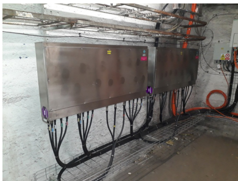
Obrázek 1: RRU „hnízdo“ s napájecími boxy
