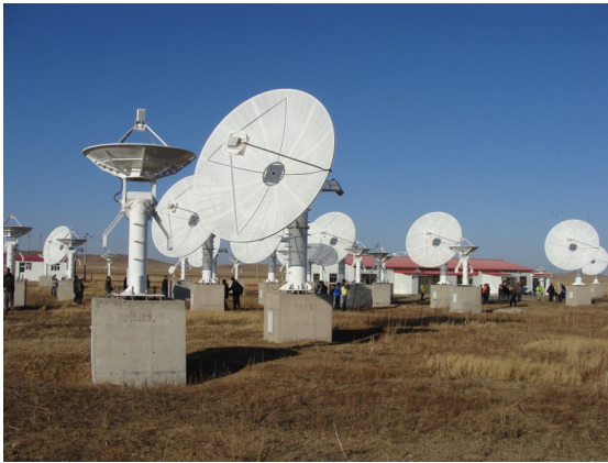
Obrázek 4: Centrální část spektro-radioheliografu MUSER v horské stepi v čínské provincii Vnitřní Mongolsko; budova v pozadí ukrývá i srdce přístroje – dedikovaný rychlý počítač/korelátor
